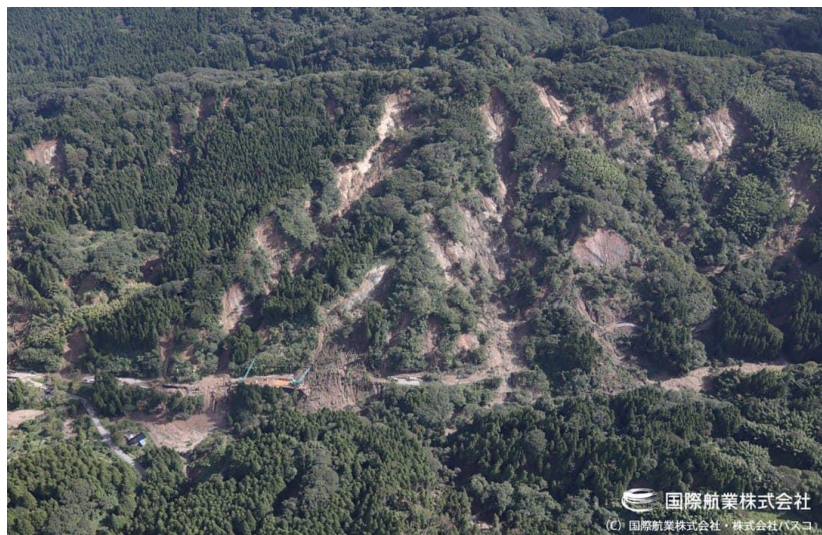
中屋トンネル北側の道路（右側がトンネル坑口方向）
